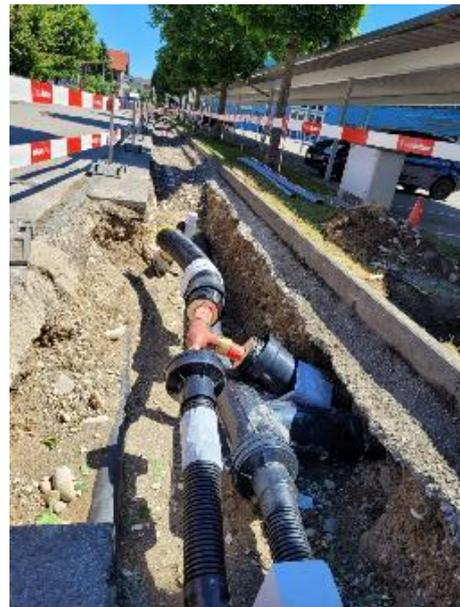
Abbildung: Rohrleitung mit T-Stück für Anschluss Landi in der Schulriederstrasse
